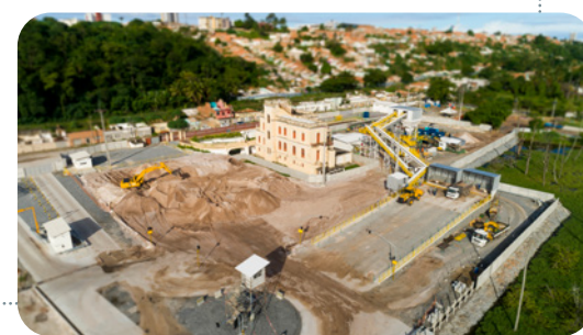
Canteiro central da obra de fechamento de poços de sal
